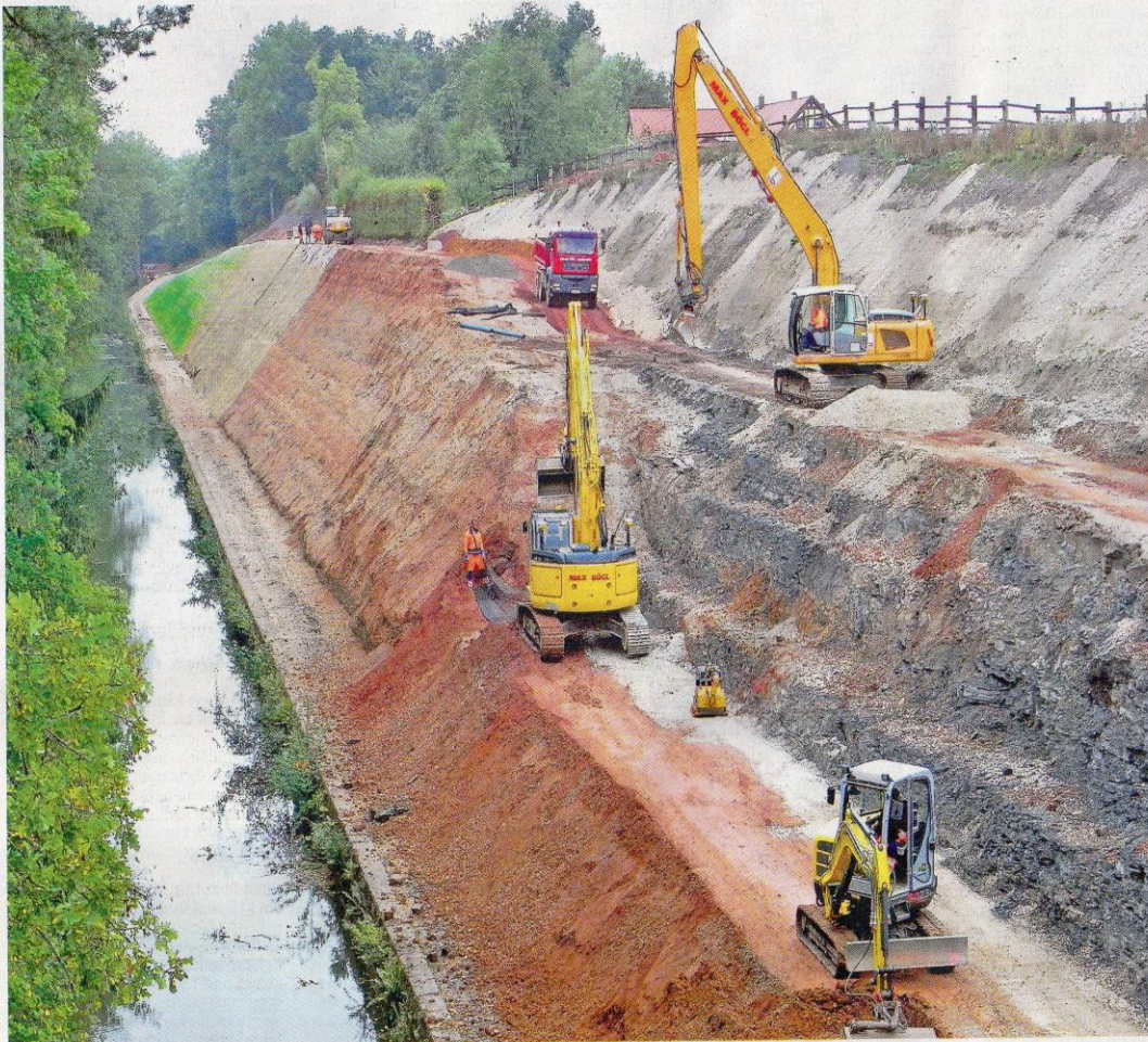
Zwei Jahre waren die Bagger am Dörlbacher Einschnitt im Einsatz, um den dort ins Rutschen gekommenen steilen Böschungshang abzuflachen und zu erneuern. 80.000 Kubikmeter Material wurden hier bewegt. Foto: Schröder
