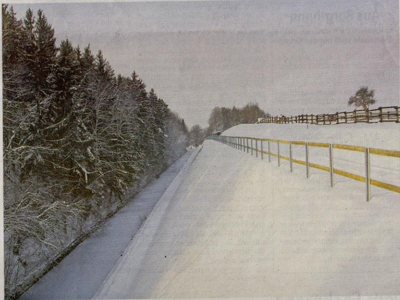
Jetzt sind die Baumaßnahmen abgeschlossen, die Böschung präsentiert sich wie zur Bauzeit im Jahr 1840 – gerade und ohne jeden Bewuchs. Foto: Blinten
